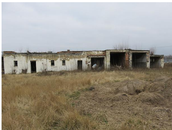
Garáže/ošipáreň, parc. č. 4287/19
