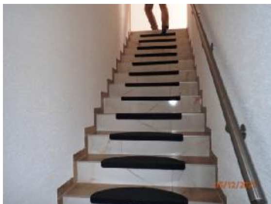
Schody na II.NP
