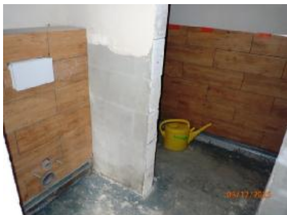
WC 1.02 a 1.03 v prístavbe
