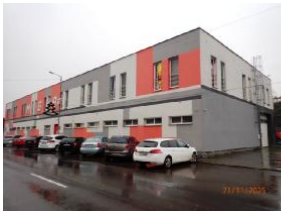
Pohľad na budovu z JV strany
