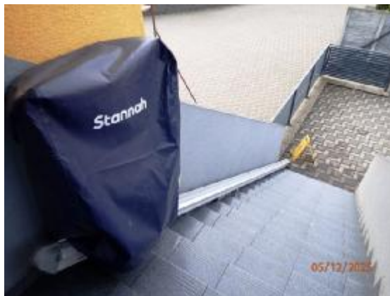
Vonkajšie schodisko na terasu budovy
