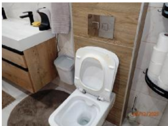
WC Geberit v kúpeľni 1.05
