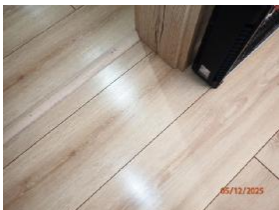
Detail podlahy kancelárie
