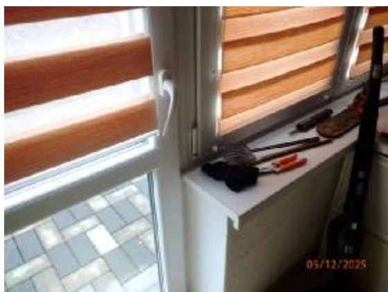
Detail okna z kancelária na terasu
