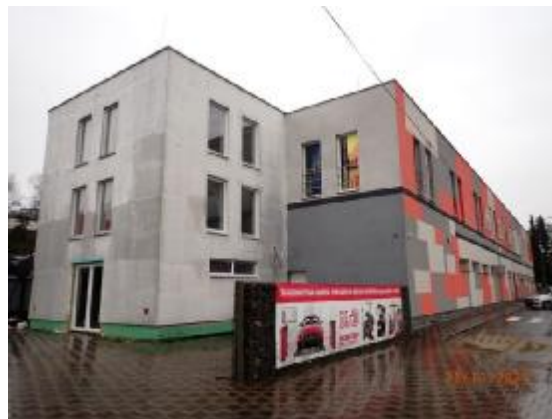
Pohľad na budovu z JZ strany
