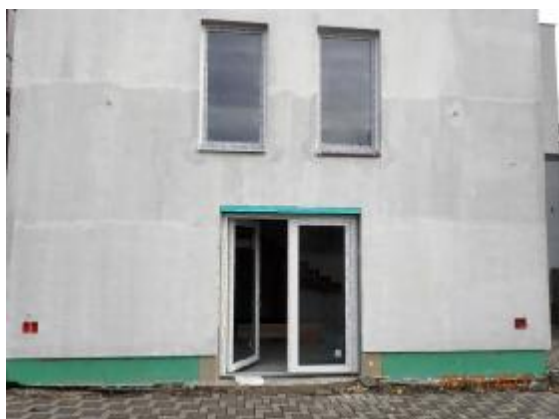
Vstup do prístavby budovy zo záp. strany
