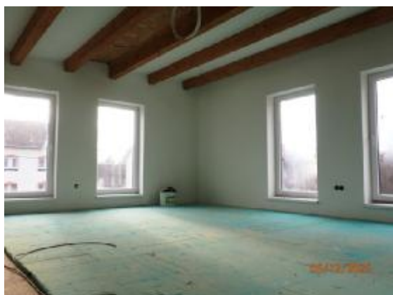
Kancelária 3.01 na II.NP prístavby
