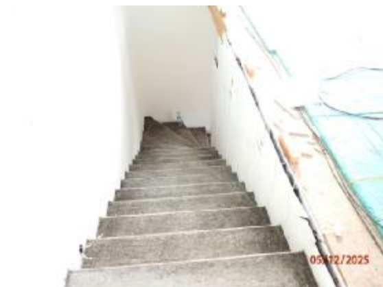
Provizórne schodisko v prístavbe
