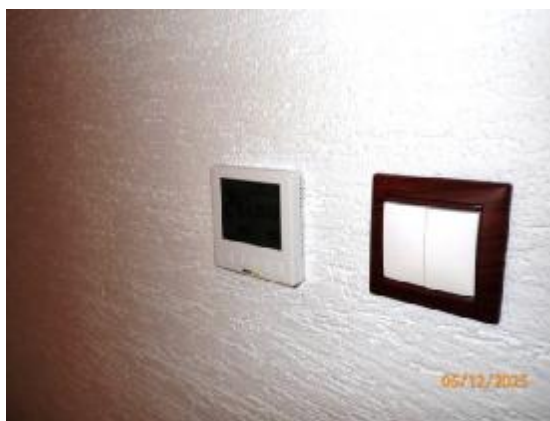
Termostat el. podlahového kúrenia
