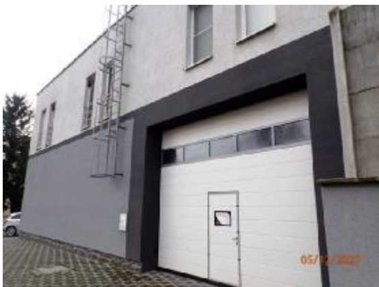
Pohľad na stavbu z východnej strany
