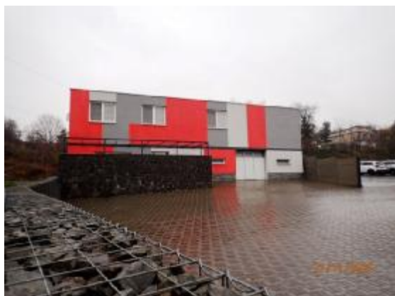
Stavba na parc. 2279/7 a /10
