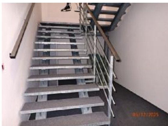
Schodisko v budove
