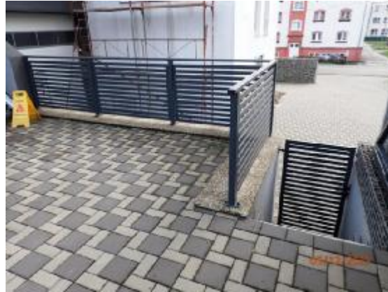
Plot a schodisko vo dvore na parc. 2279/8
