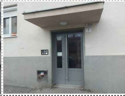
Vstup do domu zo SV strany
