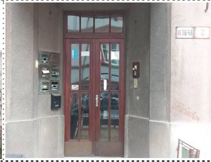
Vstup do domu Z JZ strany
